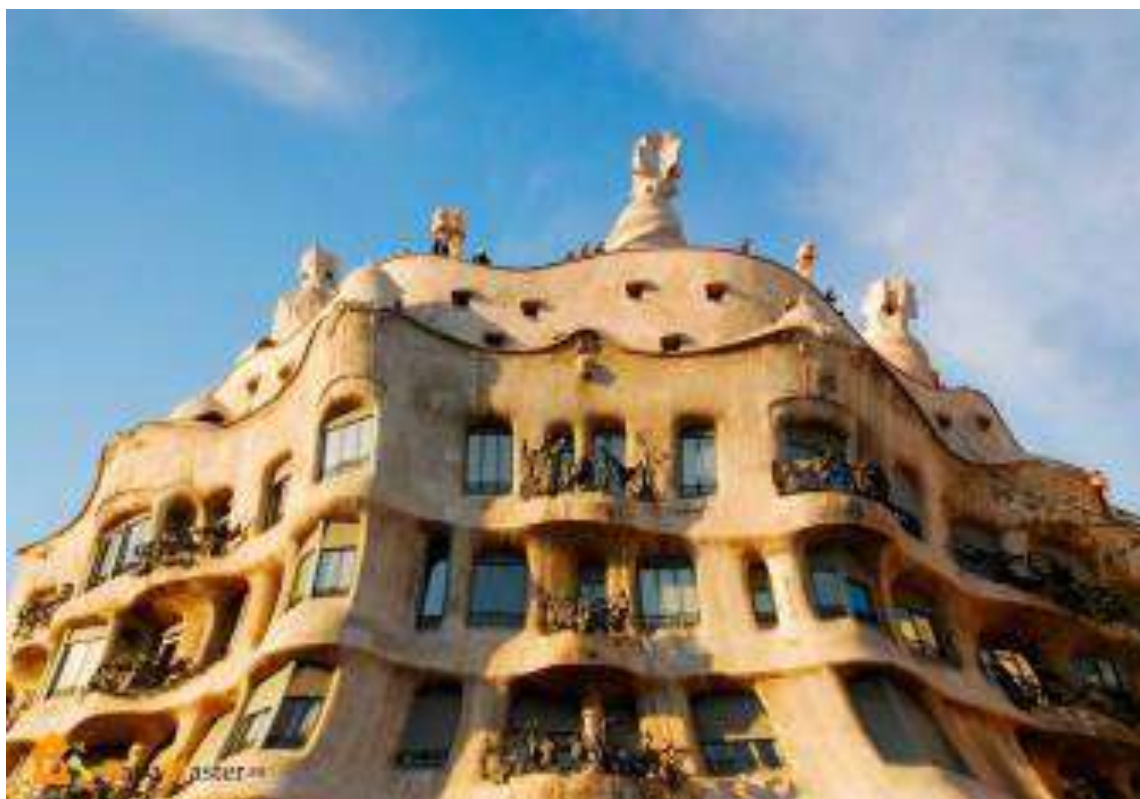
Рис №4. Біоніка в архітектурі , Будинок Міла Антоніо Гауді в Барселоні.
